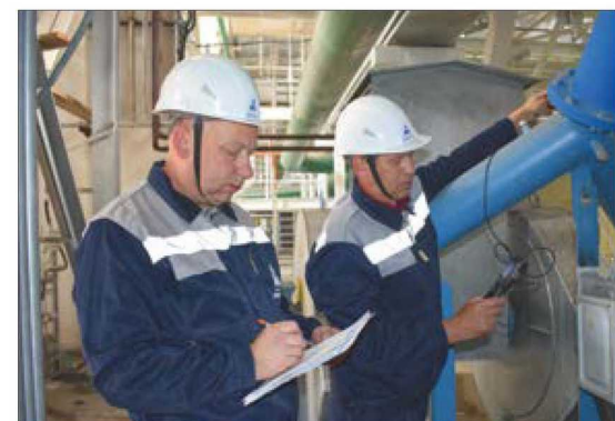
Служба наладки и испытаний теплотехнического оборудования
